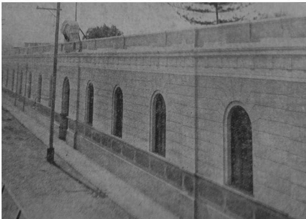
Fig 3. Fachada de la Escuela Normal de Varones de Lima (1912)
